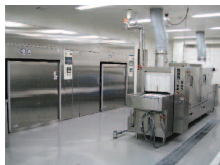
図4 洗浄室の内観
